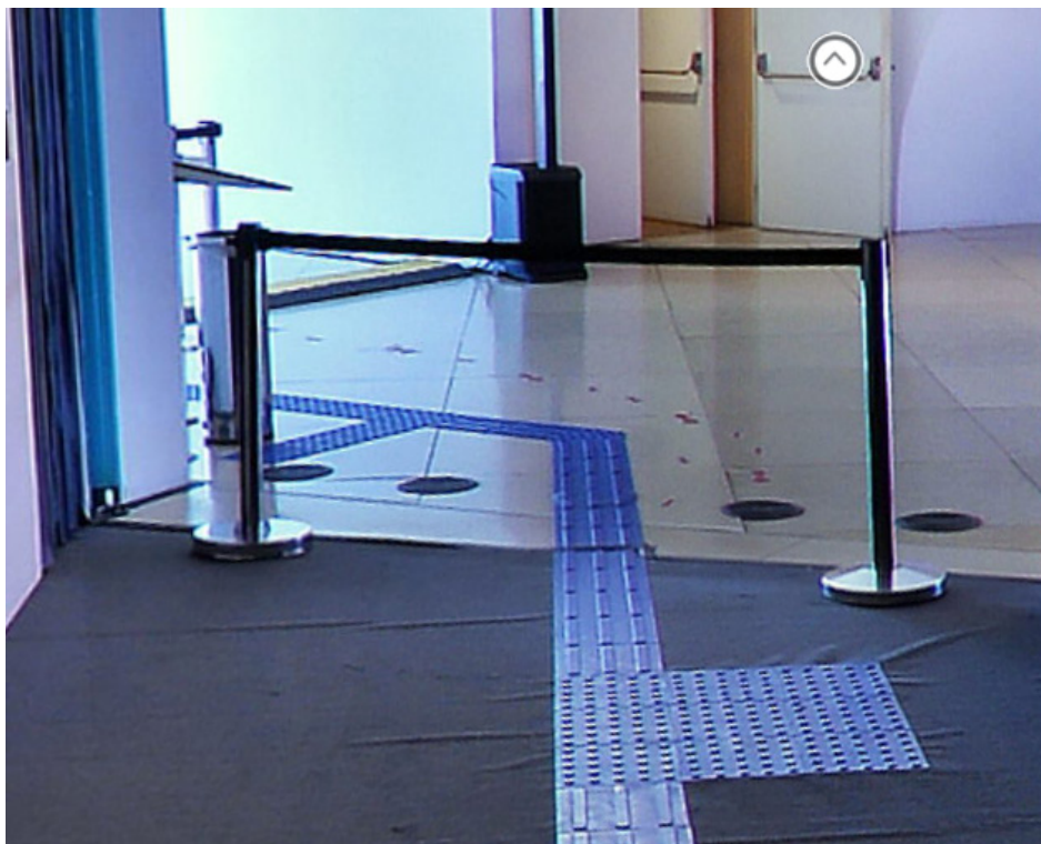
Figura 4- barreira sobre o piso tátil
